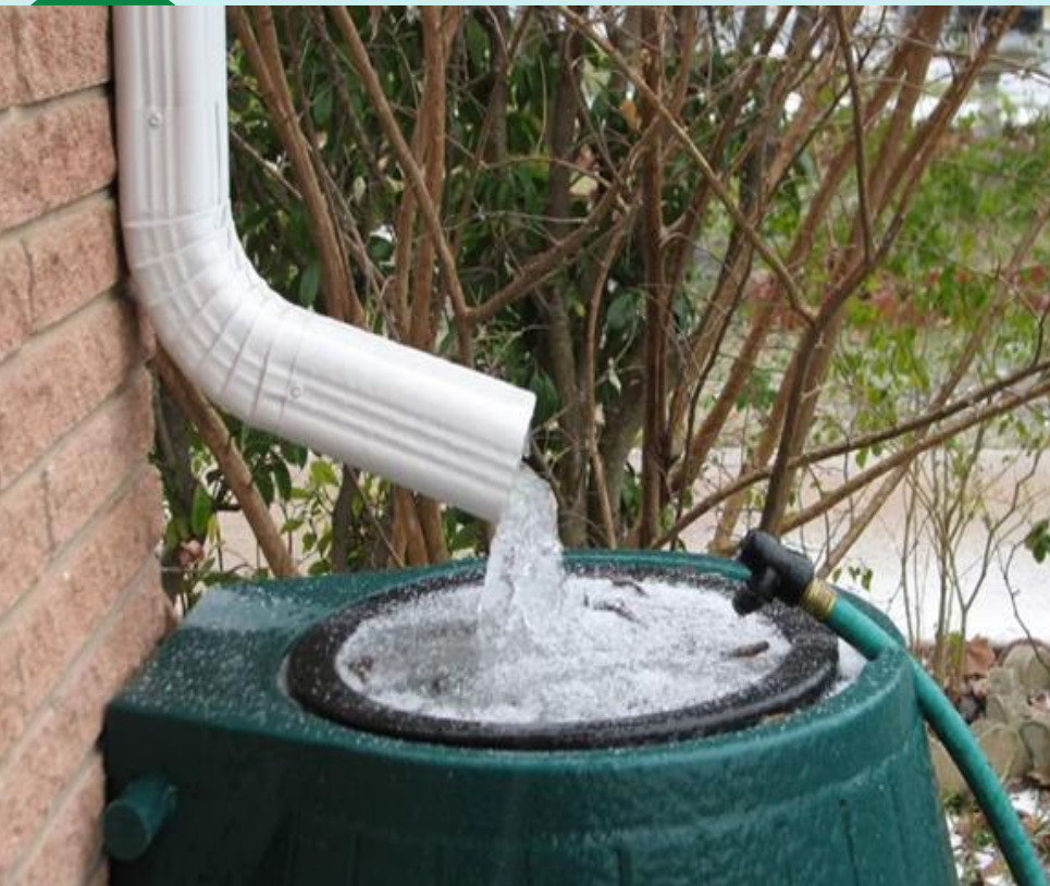
Amenajarea unui sistem de înmagazinare a apei meteorice
